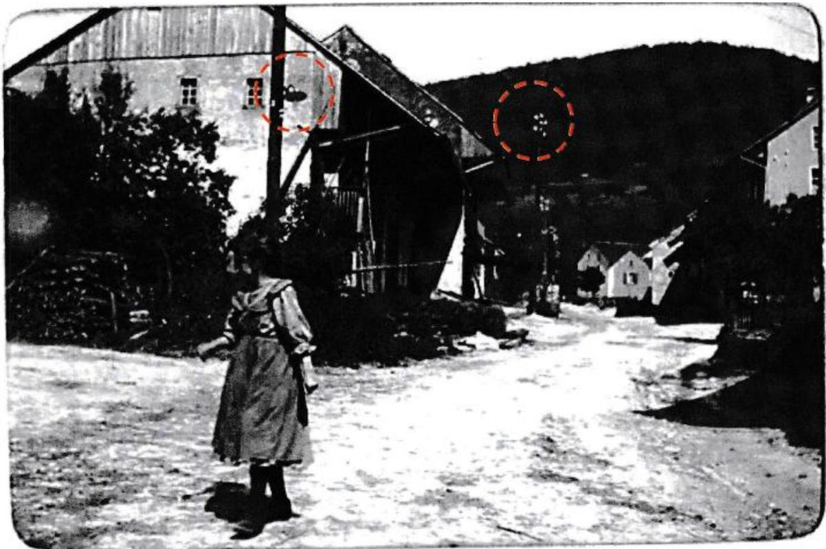
Dieses Foto aus dem Jahr 1909 zeigt eine elektrische Strassenlampe und im Hintergrund eine Elektrostange mit mehreren Isolatoren. Die Telefonleitungen benötigten .....
